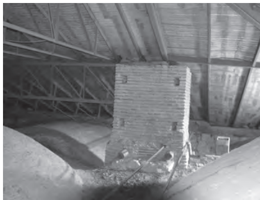
Figura 11 Machón de fábrica de ladrillo, bajo cubierta Santos Juanes (fotografía de R. Bellido)
