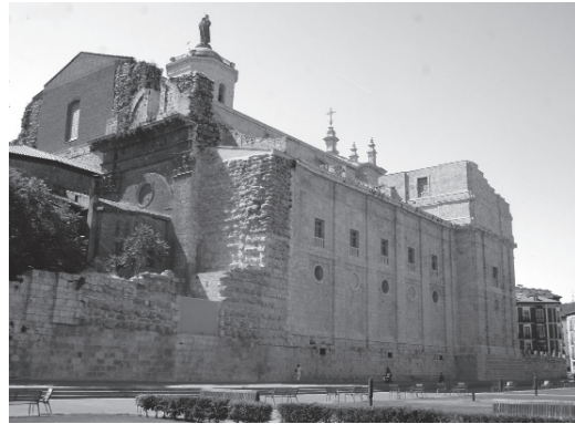
Figura 1 Fotografía de la fachada del Evangelio de la Catedral de Valladolid en que se aprecia la fábrica inconclusa a la altura del crucero y la torre desmochada a los pies (foto de los autores 06/06/2015).
