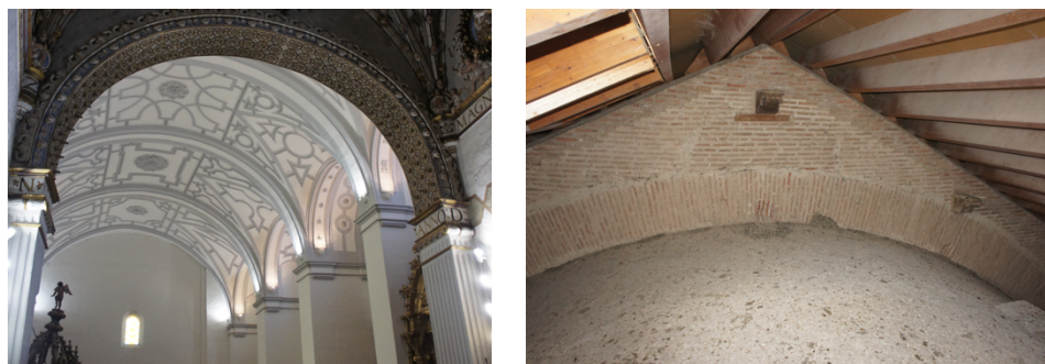
Figura 1: A la izquierda imagen de las bóvedas de la nave y a la derecha imagen del bajo cubierta de la Iglesia de Santa María del Castillo de Villaverde de Medina.
