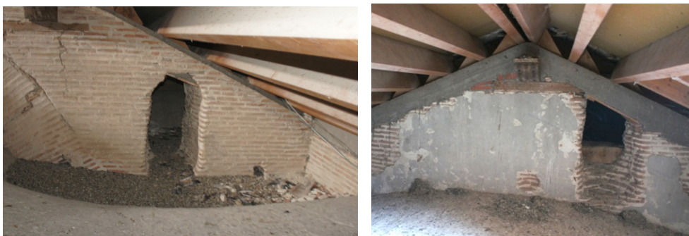
Figura 2: Huecos de paso abiertos en la zona superior de los arcos.
