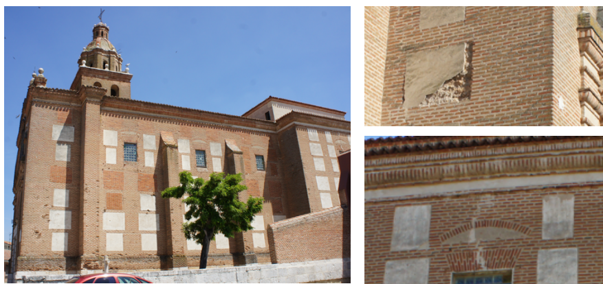
Figura 3: Vista de la Iglesia desde la plaza mayor y detalles de los muros.
