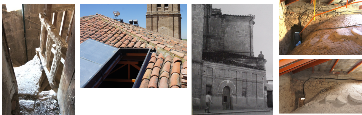
Figura 3: Acceso a bóvedas y tejado de nave central en parroquia de Nava del Rey.
