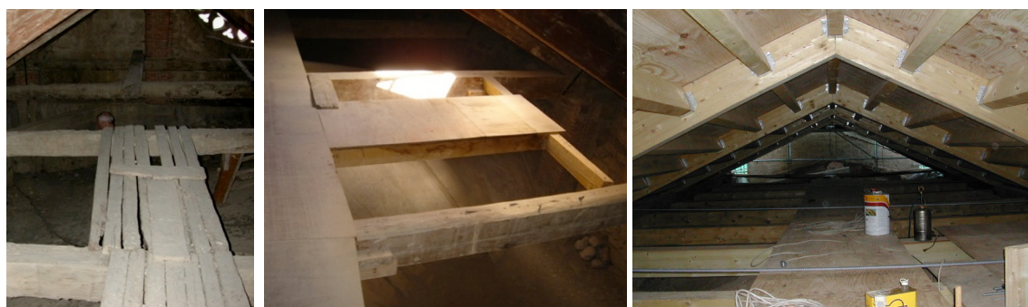
Figura 4: Pasarelas en bajo cubierta de catedral de Palencia e iglesia de Santa María de Hijosa en Boedo.
