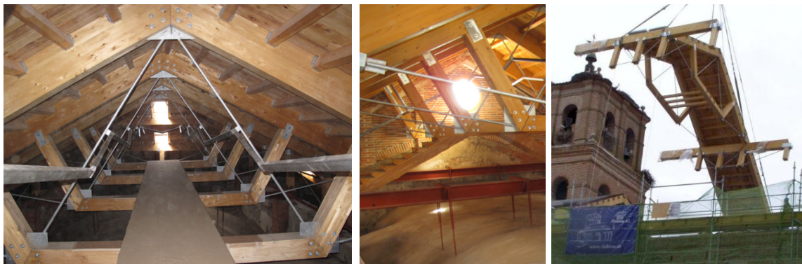
Figura 10: Montaje de la nueva cubierta de madera laminada con pasarelas en la iglesia de Alcazarén.
