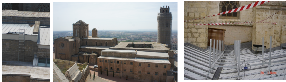
Figura 7: Terrazas pavimentadas y con pendientes muy ligeras en la Catedral vieja de Lérida y estructura de pasarela para revisión de cubierta de chapa de zinc sobre el ábside de la catedral de Palencia (2008).
