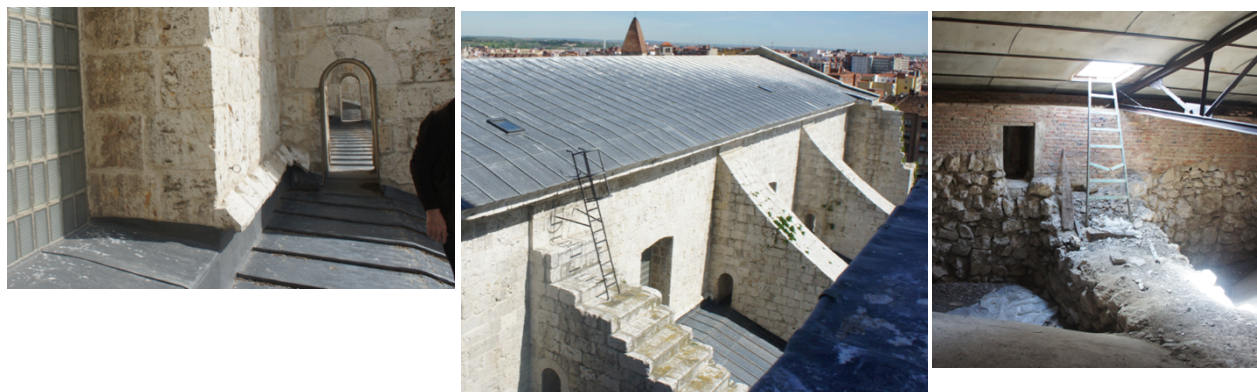
Figura 5: Acceso actual a las cubiertas en la catedral de Valladolid.
